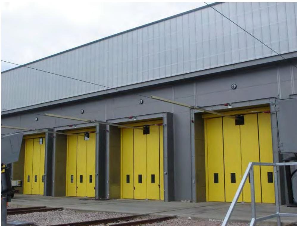
**Figure 4 : Illustration des portes à vantaux**
